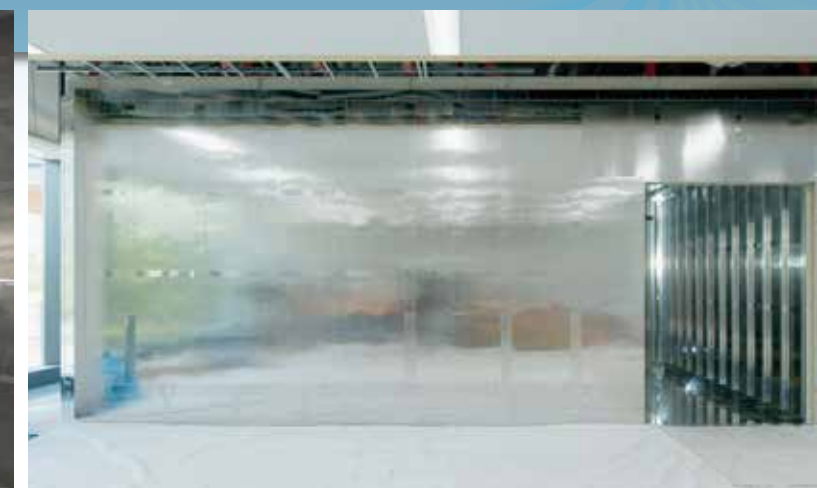
ドアのない2層磁気シールドルーム (某研究施設)
